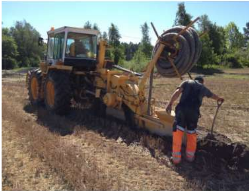
Grøfting med Rødtakshjul. Grøfting under gode, tørre forhold gir best resultat. Foto: Arle Haugen
