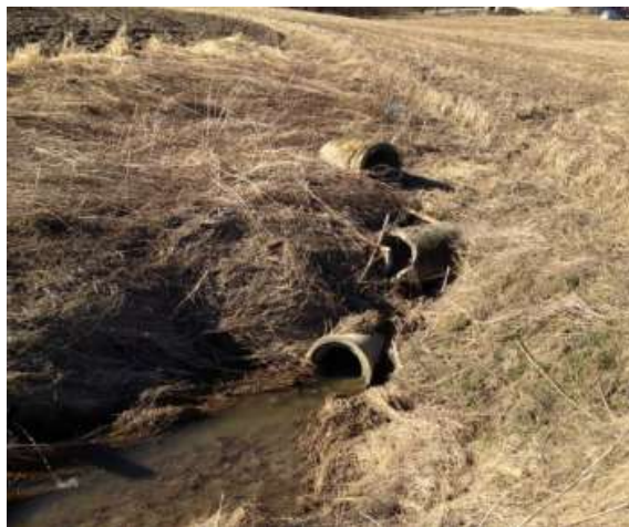
Renovering av lukkingsanlegg
